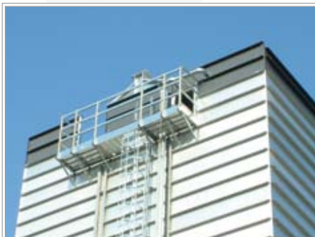
Vanjska platforma za pregled External platform for inspection
